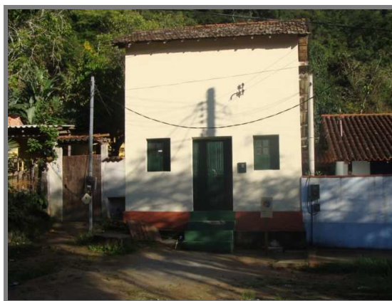
Foto 3 – Galpão na Vila do Abraão.
